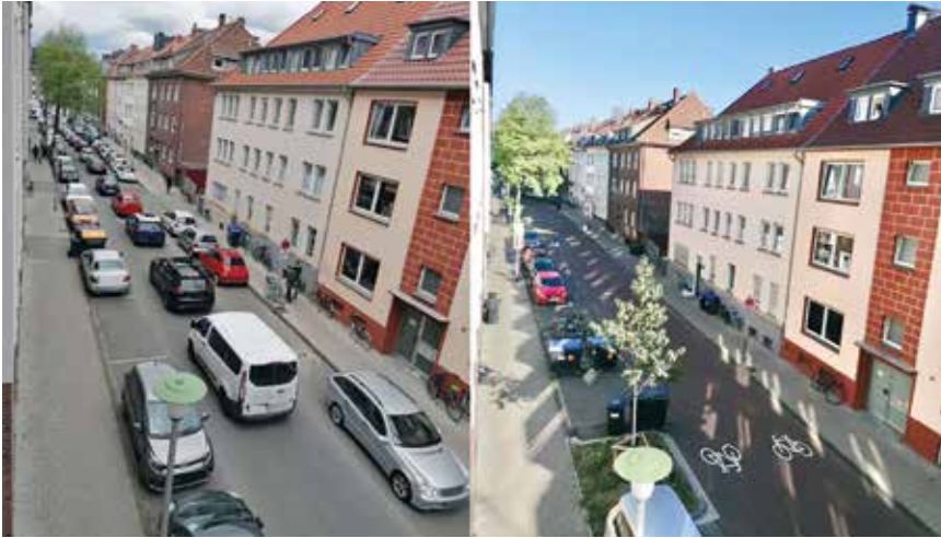
Die Schillerstraße vor und nach dem Umbau zur Fahrradstraße Plus – Foto: Stadt Münster
