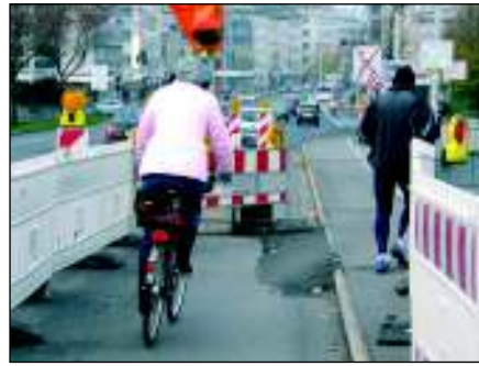
... und wieder auf den Gehweg am Ende der Baustelle
